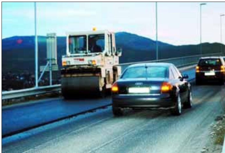
SORTLAND: Sist uke ble den gamle asfalten fjernet fra Sortlandbrua og lagt på Roa-vegen i Eidsfjord. Sent mandag kveld var mannskapene i gang med å legge nytt dekke på brua over Sortland-sundet. Det var kolonnekjøring mens arbeidet pågikk, og det ble derfor noe venting for trafikantene. (Foto: Svein-Henry W. Johansen)
