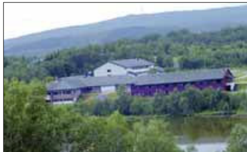
En stor bygningsmasse i tillegg til hangarer står klar til å bli tatt i bruk ved Evenes Flystasjon. (Foto: OEM)
