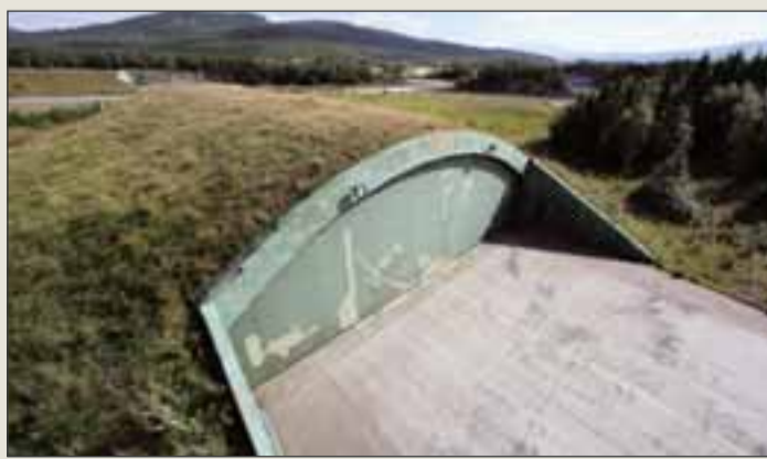
KOSTER: Legger Forsvaret ned på Evenes, vil det koste. 10 millioner vil gå til bare å mure igjen 36 slike sheltere. (Foto: Ragnar Bøifot)
