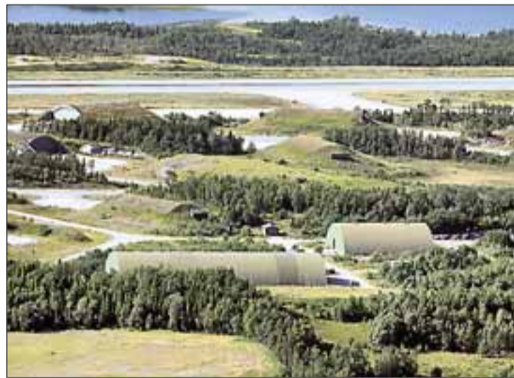
EKSERSERHALL: Det er ifølge Forsvaret behov for å bygge kaldlager og ekserserhaller på Evenes – i tillegg til de som allerede finnes og står tomme. Disse hallene har vært brukt for forhåndslagret utstyr.
