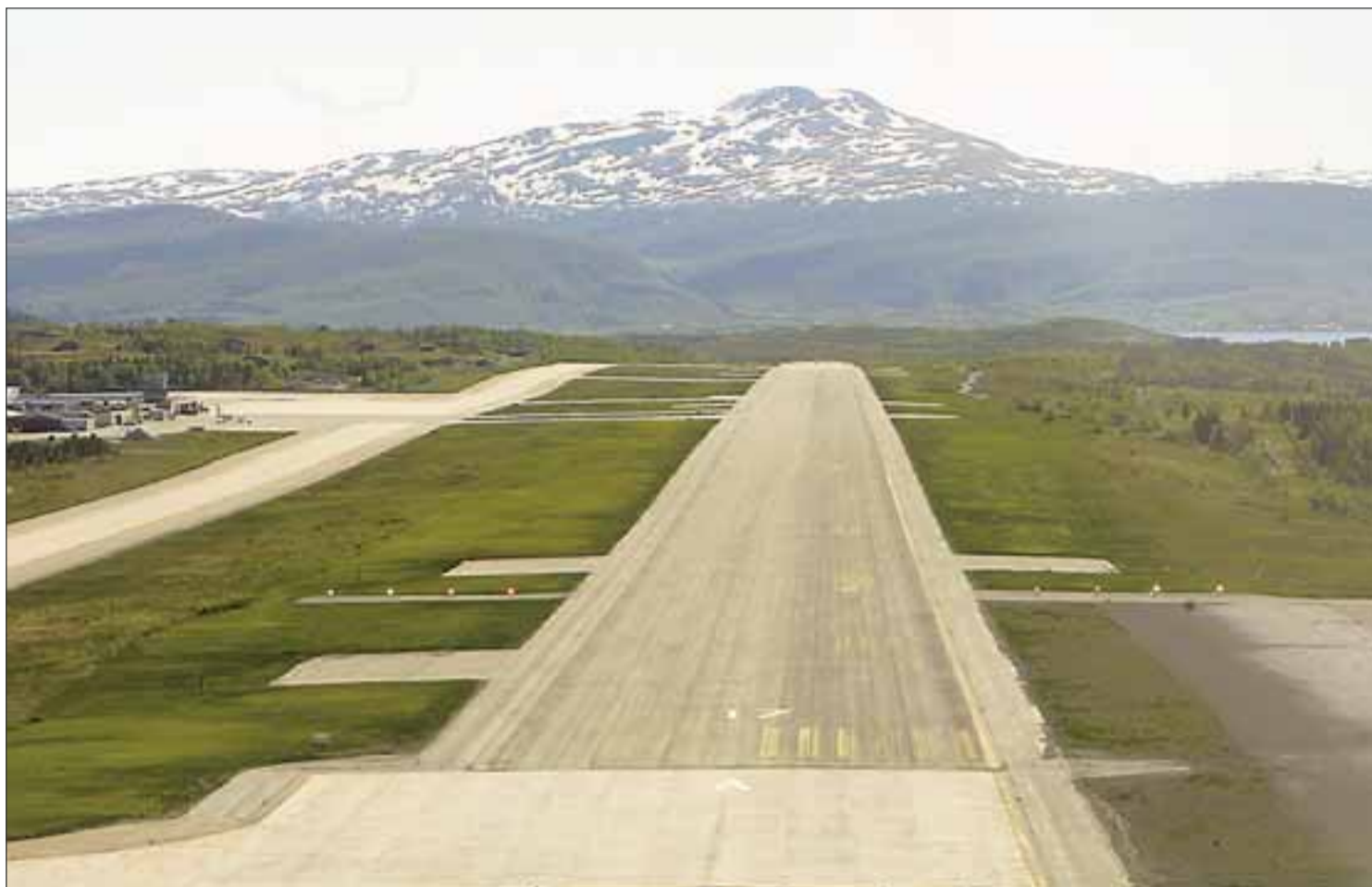
MÅ BYGGE NY: Ifølge Forsvaret må det blant annet bygges ny taksebane på vestsiden (til høyre i bildet) for at Evenes skal kunne fungere som landets hovedflystasjon. (Foto: Ragnar Bøifot)
