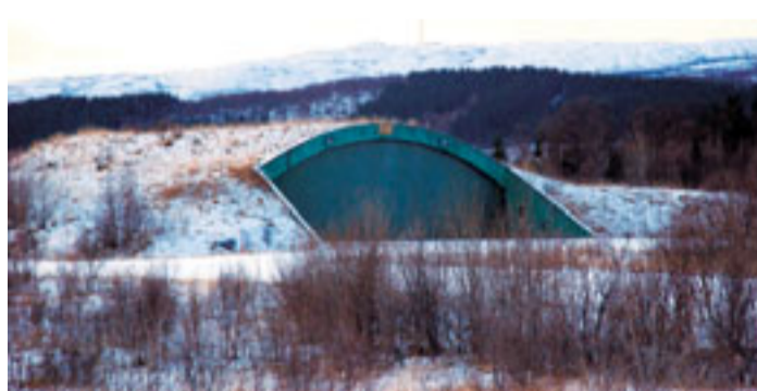
OSMARKA: I forbindelse med flyplassen er det bygget et av Europas største fjellanlegg, med 20 fjellhaller på til sammen 32 000 kvadratmeter.
