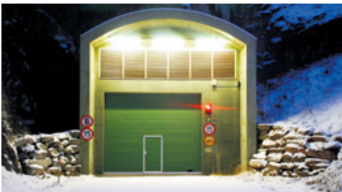
SHELTER: Her er nummer 14 av i alt 36 topp moderne hangarer for jagerfly.
